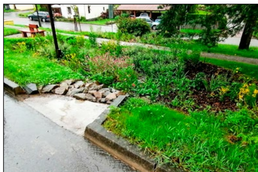
Zasakování vody v centru obce Ruprechtov prostřednictvím dešťových záhonů. Adaptační opatření mohou být zároveň účinná i krásná.
